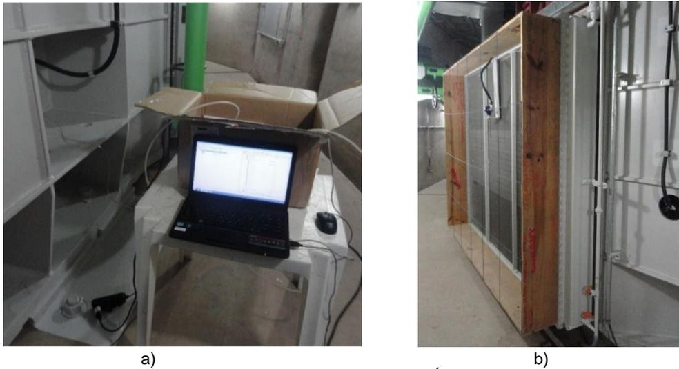
Figura 3.4 – a) Exemplo da execução das medições de campo. b) Áreas delimitadas para medição de vazão volumétrica de ar passando por um trocador de calor.
