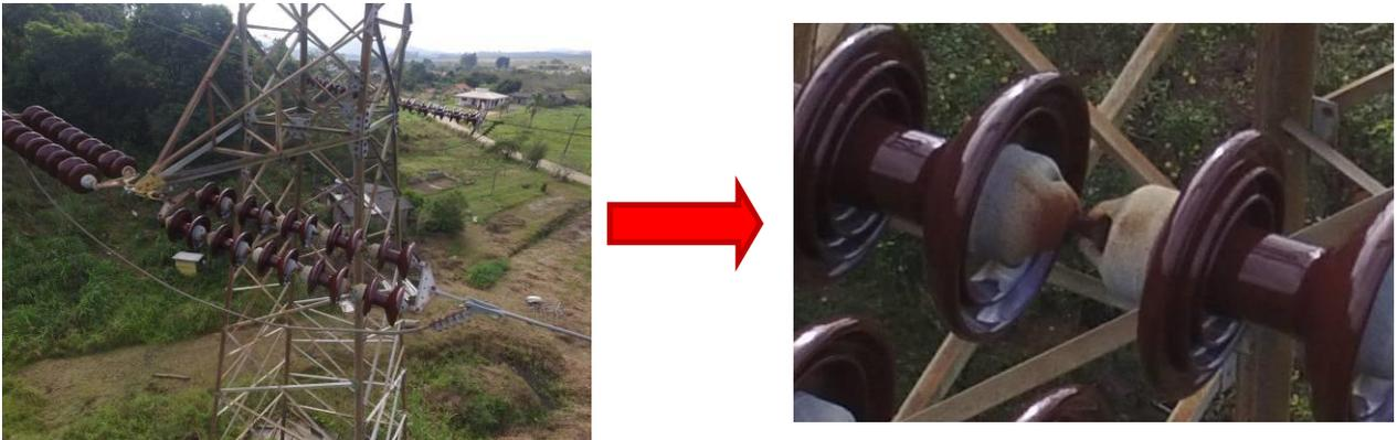
FIGURA 9: Cadeia de isolador de ancoragem com bolete com corrosão
