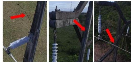
FIGURA 15 – Estruturas com fio terra partido e oxidado
