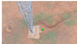
FIGURA 9 – Zoom na base de uma torre, com um comentário registrado no software indicado a possibilidade de erosão
