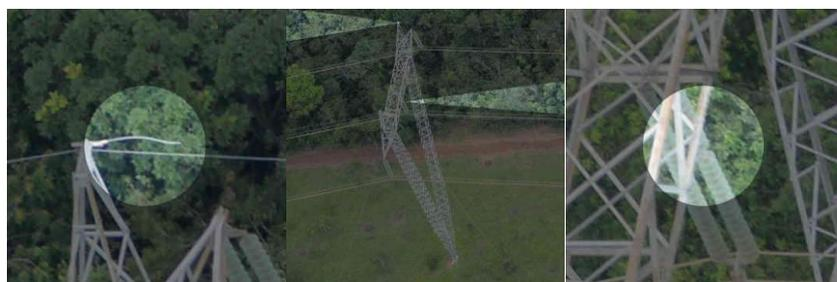
FIGURA 11 – Defeitos encontrados: (a) Rabicho solto. (b) Visão geral da torre. (c) Isolador quebrado
