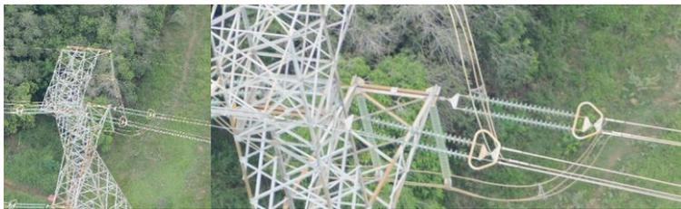
FIGURA 8 – Destaque para a qualidade das imagens, permitido à equipe de inspeção avaliar o estado de elementos físicos
