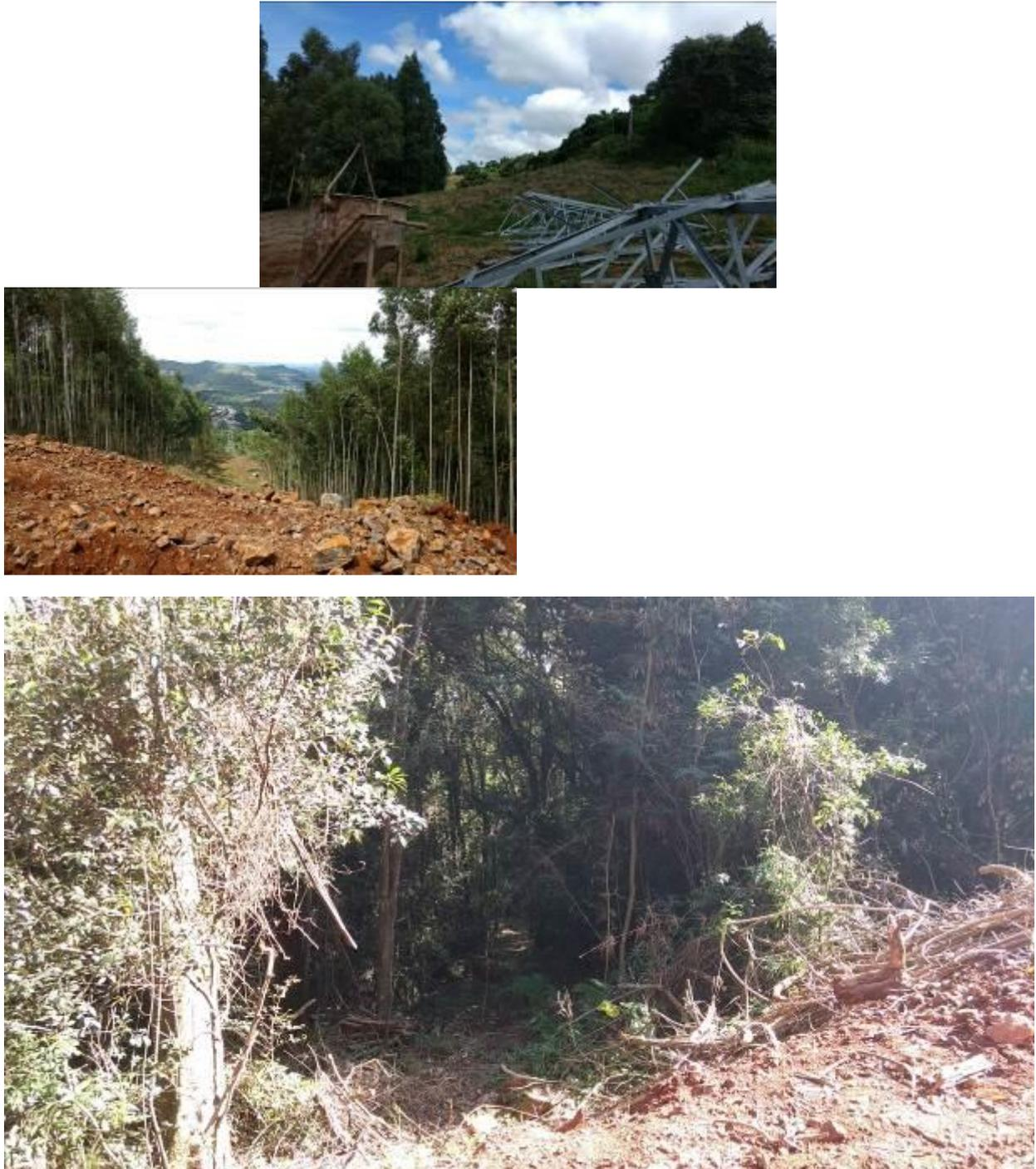
Figura 2 – Abertura de picada para passagem de cabo piloto
