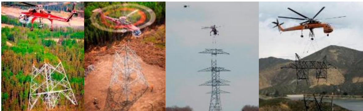
Figura 5 – Transporte e montagem de seções de torres autoportantes (fonte: LUMRY Corp.; USA)
