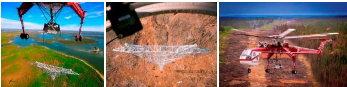
Figura 4 – Sequência de transporte e montagem de torres estaiadas com S64 (fonte: LUMRY; USA)
