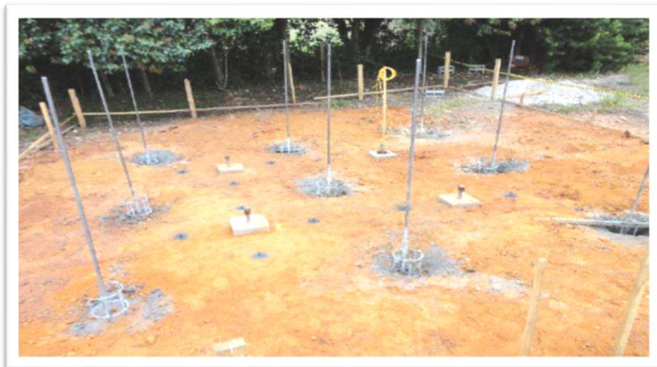
FIGURA 7 – Detalhe das sapatas e tirantes no campo de testes em Bateias
