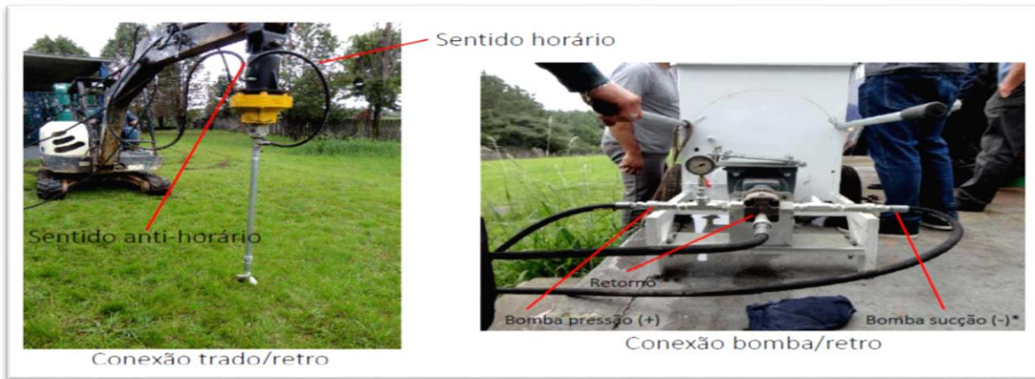
FIGURA 4 – Detalhes das conexões das mangueiras à perfuratriz e a bomba de sucção do reservatório de calda aglomerante.
