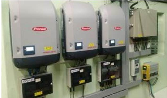
FIGURA 2 – Sistemas On e Off Grid: Inversores, quadros de força, controlador de carga e banco de baterias.
