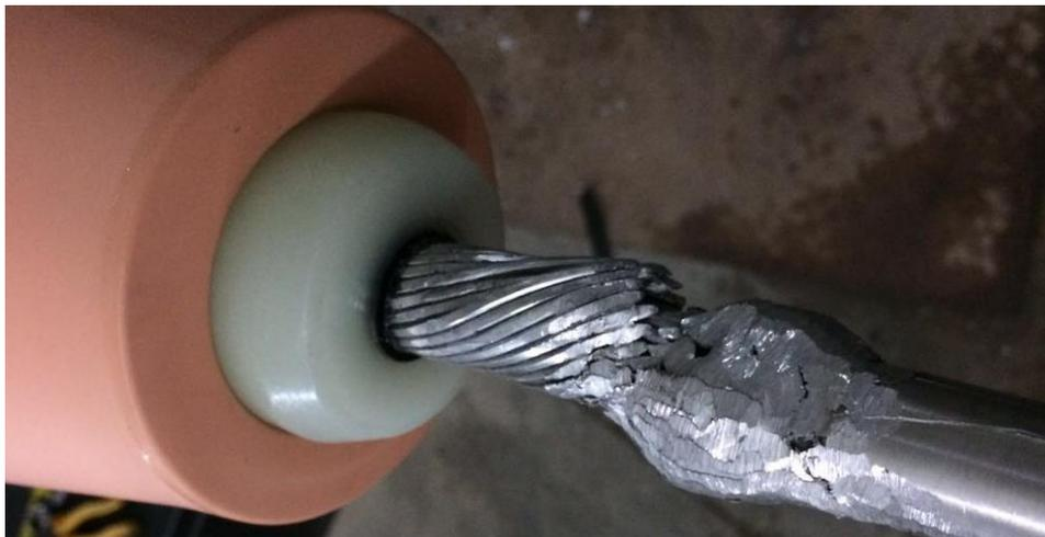
Figura 9 – Conexão do condutor do cabo ao condutor da bucha de passagem
