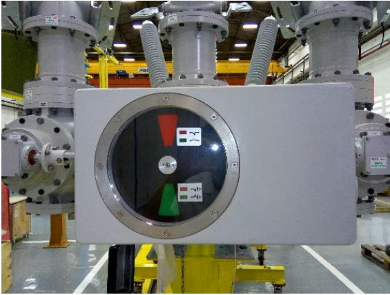
Fig. 13: Indicador de posições do seccionamento principal e de aterramento
