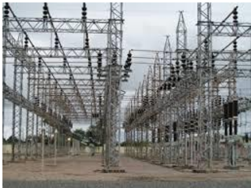
Fig. 20: Arranjo com barramentos rígidos
