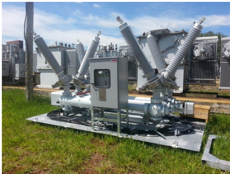
Figura 17 – Módulo híbrido compacto relocável de 145 kV montado para transporte. À direita, embaixo na foto, vê-se a cruzeta de içamento; mais ao fundo, no canto da plataforma à direita, vê-se o caixote de madeira contendo os cabos de içamento com o conjunto de anilhas de enganchamento; e fixados sobre a plataforma de arraste, enrolados em volta do equipamento, os cabos de controle.
