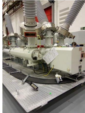
Fig. 14: Fixação dos cabos de controle na plataforma
