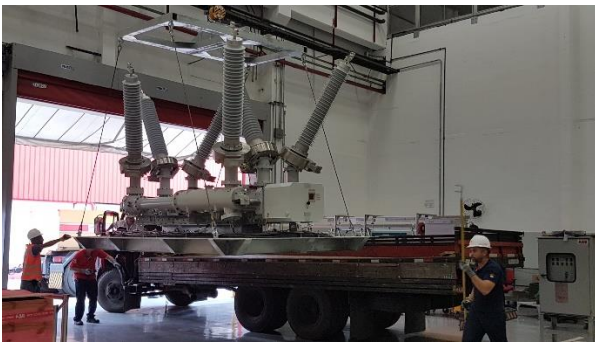
Fig. 9: içamento do conjunto para embarque em caminhão comum
