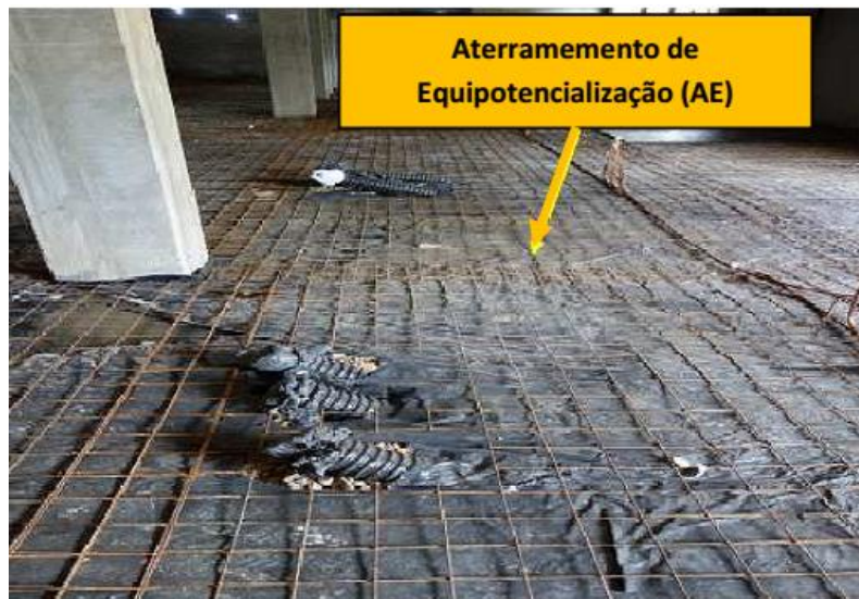
FIGURA 3 – Aterramento de Equipotencialização (AE).
