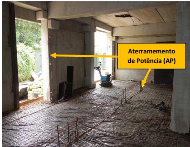
FIGURA 2 - Conductor do Aterramento de Potência (AP).
