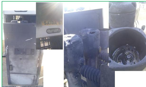
Figura 3 – Exemplo de cubículo de disjuntor de 13,8 kV à PVO sinistrado.
