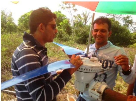
FIGURA 6 – Montagem e instalação do aerogerador
