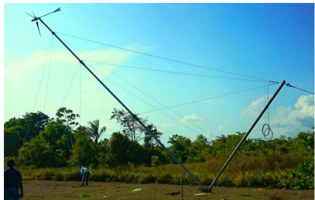
FIGURA 6 – Montagem e instalação do aerogerador
