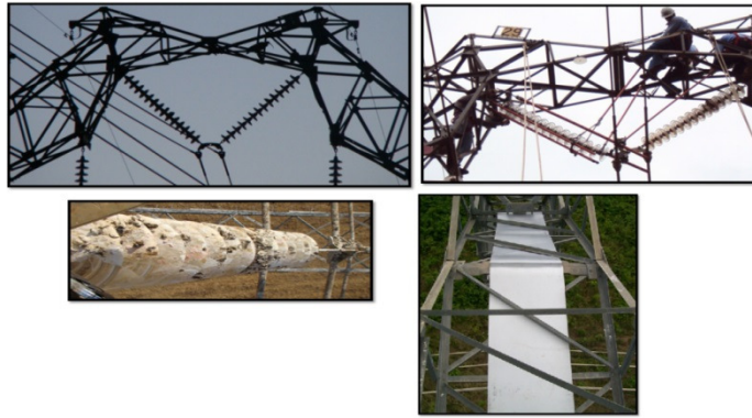
Figura 4 – Instalação de proteção contra excrementos de aves na cadeia central da torre (mais afetada)
