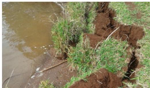
FIGURA 8: Detalhe da queda de talude na área de pasto, devido à ação de ondas.
