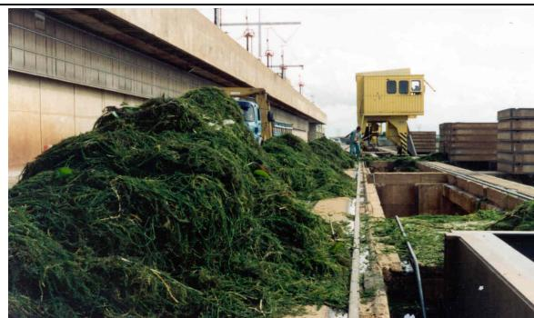
Figura 2: Resíduos de macrófitas aquáticas na barragem da UHE
