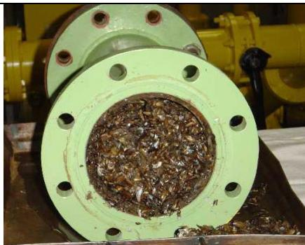
Figura 1: Impactos do mexilhão-dourado nas estruturas da UHE
