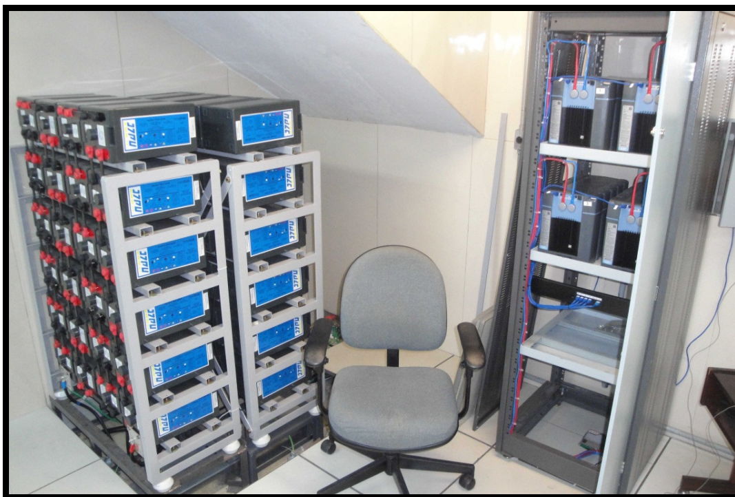
Figura 6: Visão comparativa entre as baterias chumbo-ácidas (esq) e as de lítio-íon (dir) utilizadas em um sistema retificador operando na voltagem de 48V Foto: Alexandre Pinhel Soares
